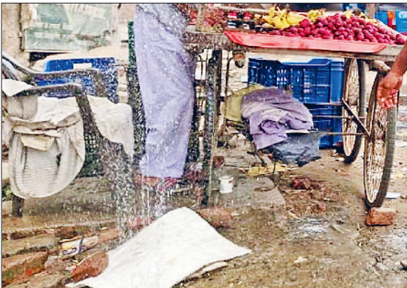
झज्जर। अंबेडकर चौक पर टूटे पेयजल कनेक्शनों से निकलता स्वच्छता पानी।
